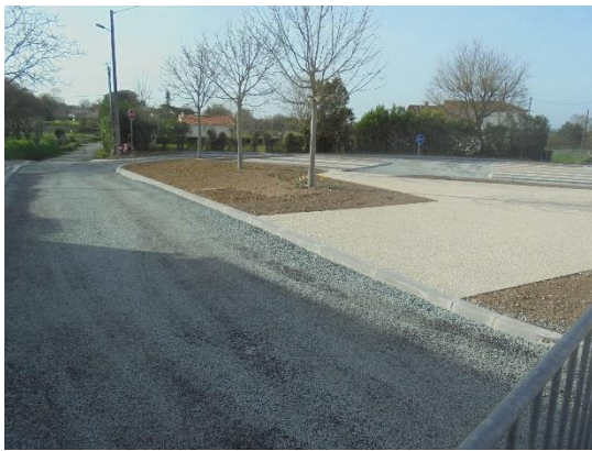
Place après travaux
