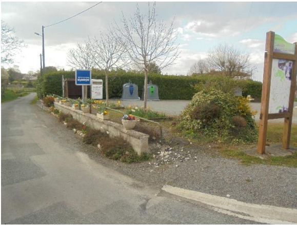
Place avant travaux
